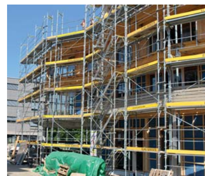
Gebäude C befindet sich noch im Bau.
