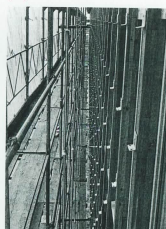
An den Fassadenpfosten werden die Befestigungen für die Lamellen montiert
