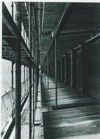
Die Fassadenlamellen hängen an Zugstäben und stützen sich innen auf Konsolen
