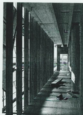
Der Fluchtweg längs der Südfassade ist vor dem Einbau der Türen noch durchgehend
