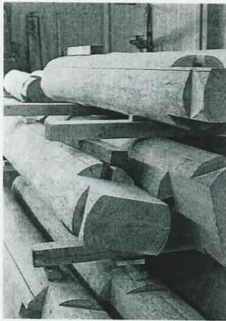
Die bearbeiteten Rundholzstützen liegen zum Einbau bereit
