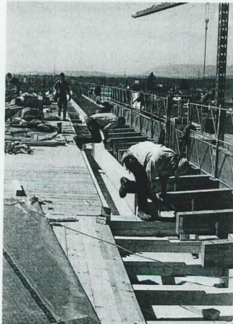
Die Vordachkonstruktion des Kaldachs wird montiert
