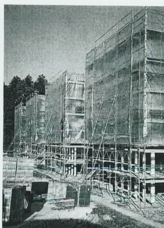
Das Internatsgebäude, ein vorgefertigter Rahmenbau ist aufgerichtet
