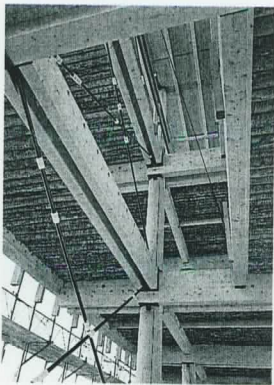
Die Tragkonstruktion während des Baus. Blick nach oben durch die Deckenaussparungen für die geraden Treppen. Baumstammstütze, Primär- und Sekundärträger sind klar sichtbar. Die Rundhölzer der Deckenelemente ebenfalls
