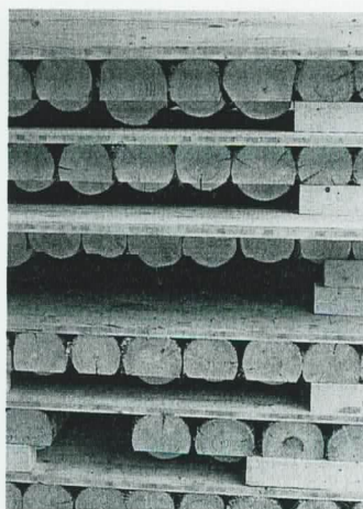
Die Deckenelemente des Schultrakts vor der Montage. Zur Befestigung der Rundhölzer lag die Platte in der Werkstatt unten
