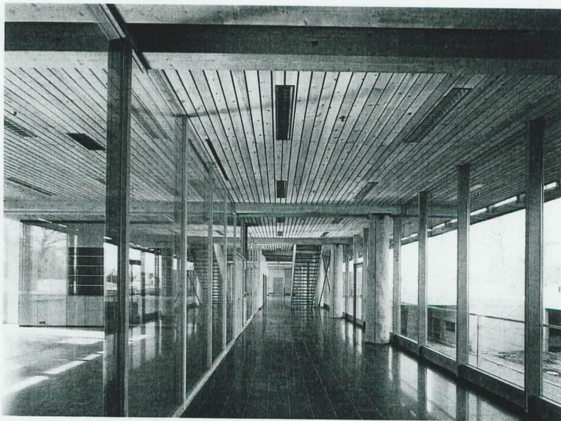
Korridor im Erdgeschoss des Schulhauses. Die zweiseitige Belichtung der Räume am Korridor wird deutlich
