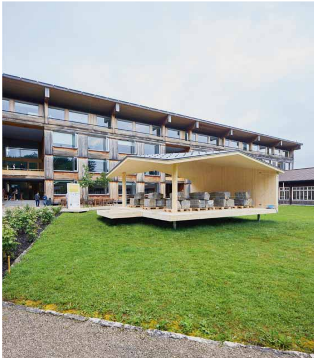
Der neue Dauerprüfstand ist mit der TS3-Technologie gefertigt. Der «Balkon» auf der linken Seite ist angeklebt und hält eine Belastung von sieben Tonnen aus. Stützverstrebenungen wie an der Decke des Hauptgebäudes werden künftig im Holzbau nicht mehr zwingend nötig sein. zv
