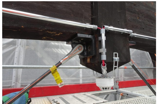
Fixation des barres de traction
