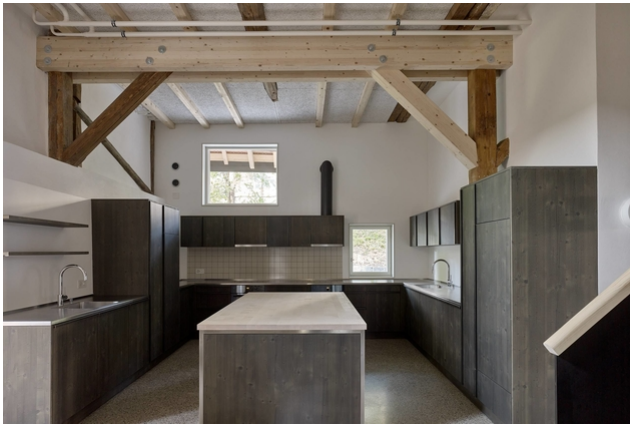
Structure porteuse renforcée au-dessus de la cuisine
