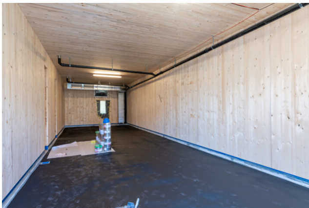
2ème étage (source : Limeco)
