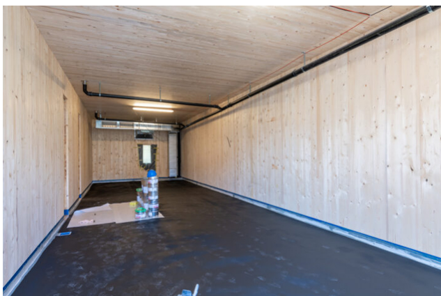
2ème étage (source : Limeco)
