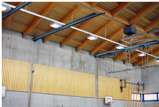
Vue de la position exposée des chevrons
