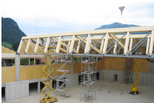
Montage de poutres en treillis
