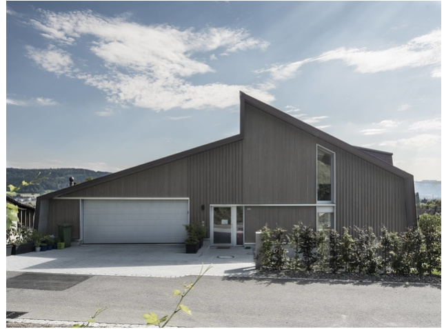
Le garage situé directement au-dessus de la chambre à coucher posait des exigences élevées en matière d'insonorisation.
