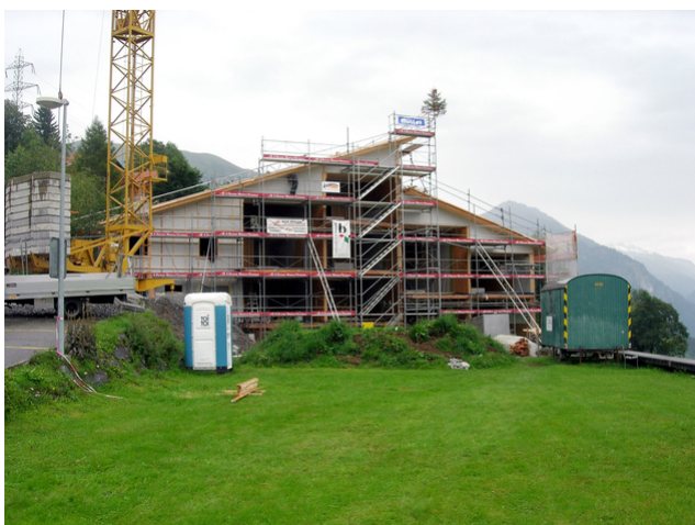
Gros œuvre du bâtiment
