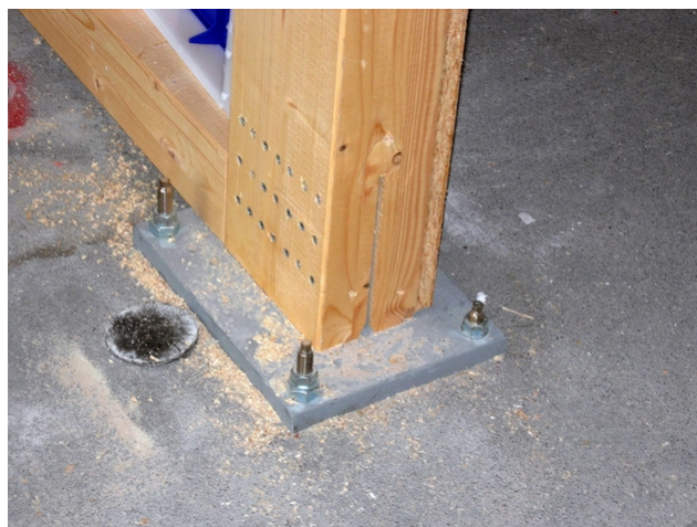
Ancrage de soutien
