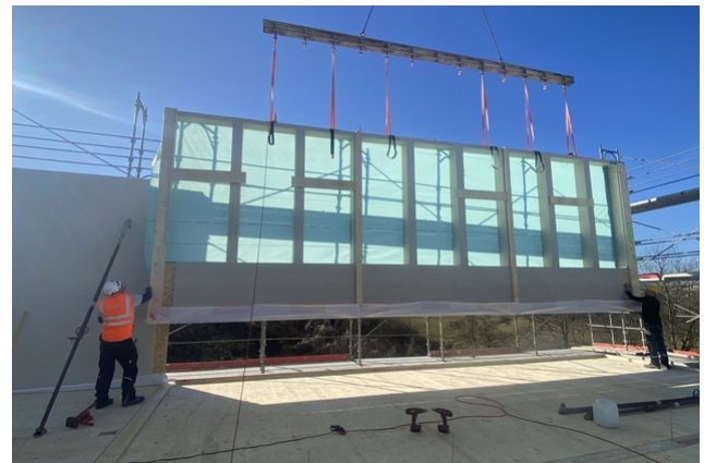
Montage d'éléments muraux préfabriqués
