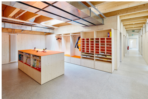
La zone de bureaux du Werkhof : Le bois a également été utilisé pour l'aménagement intérieur (Photos : Nils Sandmeier)
