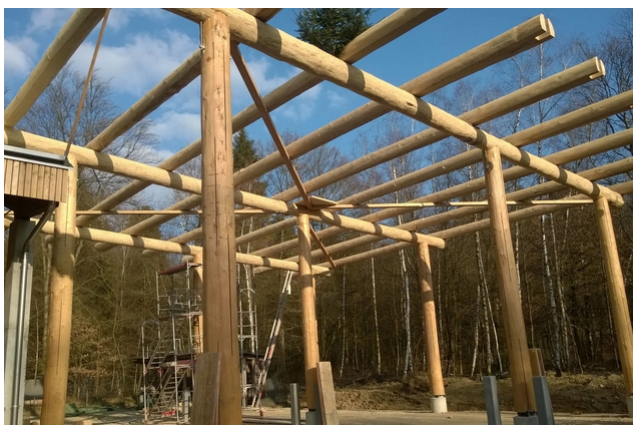
Structure porteuse après montage
