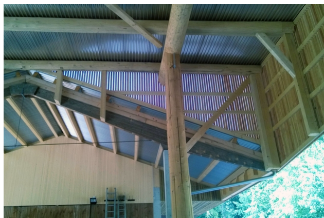
Structure porteuse dans le bâtiment fini
