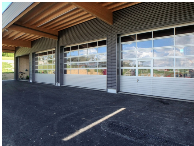
L'auvent du nouveau garage a une largeur de 5 mètres.
