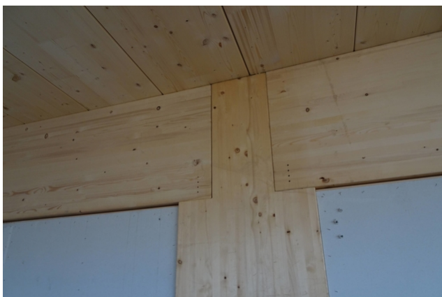
Appui des poutres sur les poteaux
