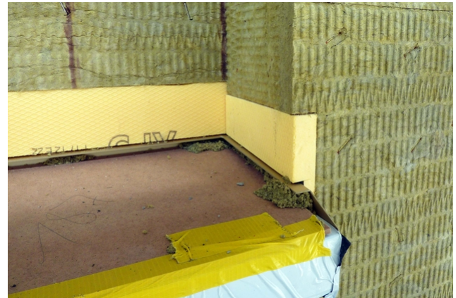
Détail de l'isolation sur le rebord de la fenêtre
