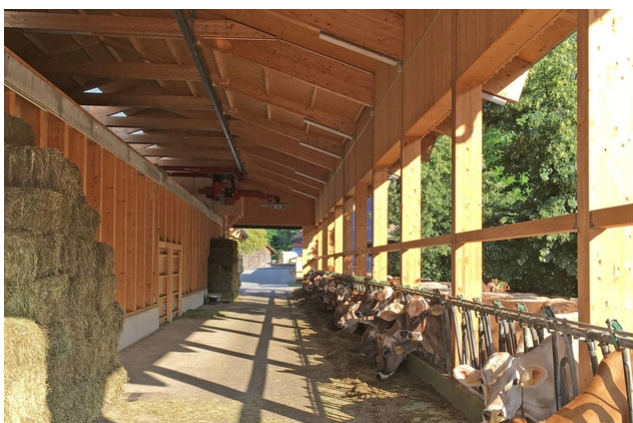
Vue intérieure de l'entrepôt de fourrage
