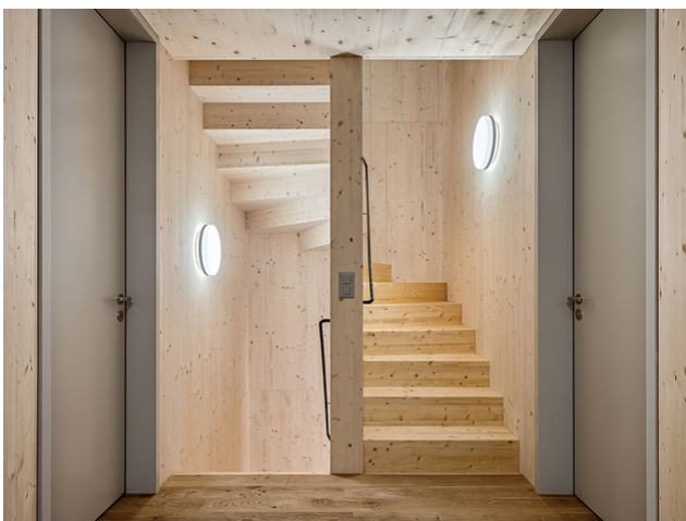
Une cage d'escalier tout en bois
