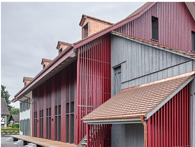
Le coffrage en bois a été peint avec une lasure à l'huile rouge oxyde
