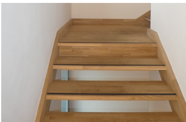
Escalier en bois
