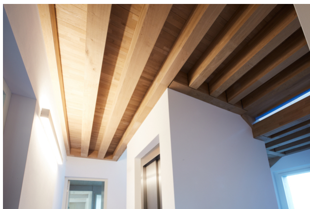
Cage d'escalier et cage d'ascenseur en bois
