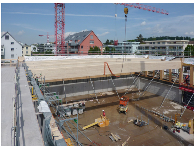
Installation de galeries de toit pour le nouveau gymnase
