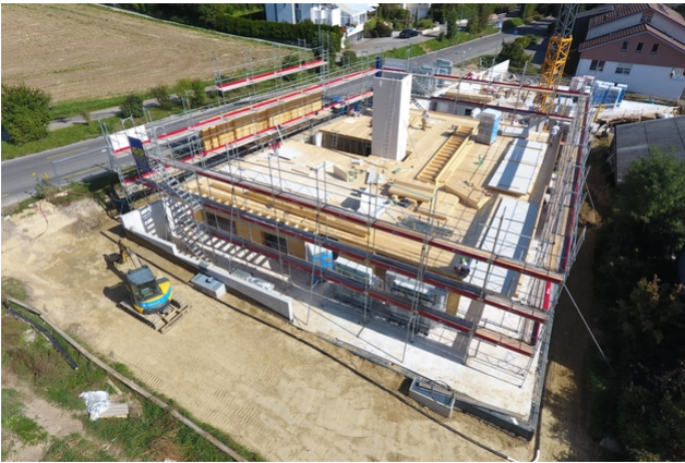
Cage d'ascenseur en CLT
