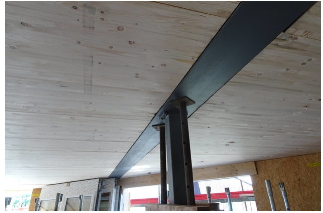
Poutrelle en acier intégrée au plafond
