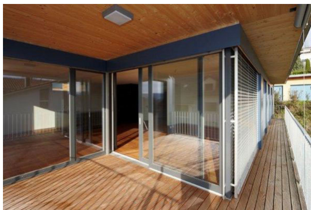
Vue extérieure des appartements sud
