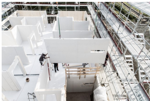
Montage des cloisons intérieures formant compartiment coupe-feu
