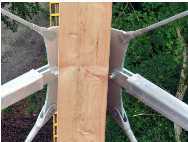
Raccord de barre de traction et de compression
