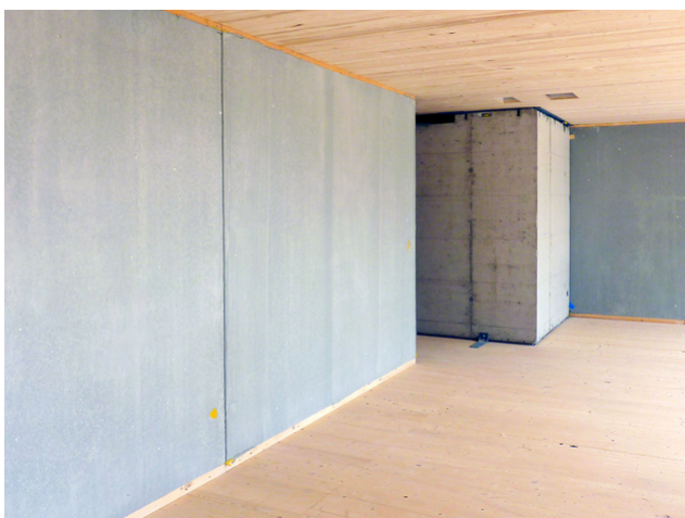
Vue du mur bois-béton
