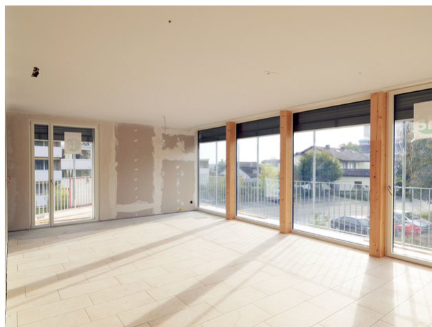
Vue intérieure de la fenêtre
