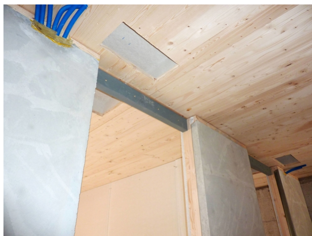
Revêtement mural comme accumulateur de chaleur
