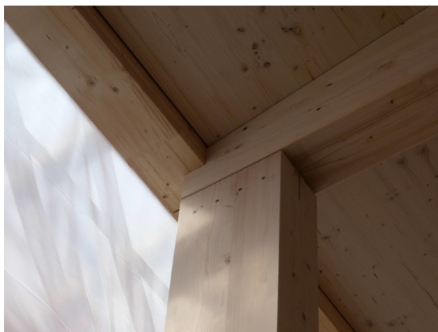
Appui Poutre sur support
