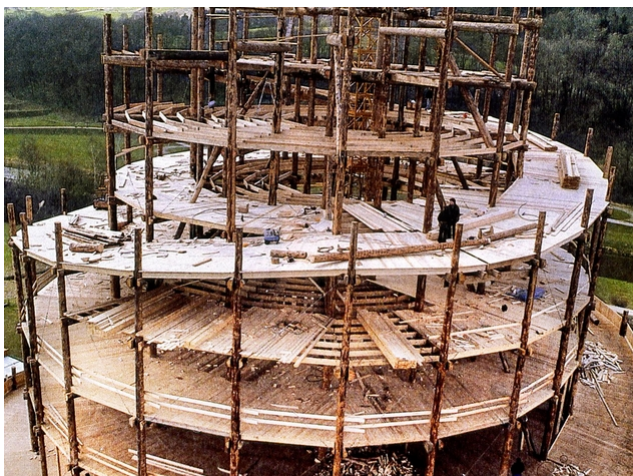
Tour en cours de construction
