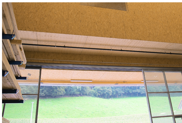
Porte coulissante sous l'aile des bureaux - 15 m en porte-à-faux avec une flexion minimale
