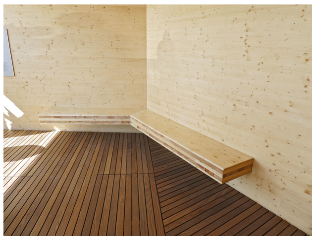
Tout en bois : les sièges de la plateforme
