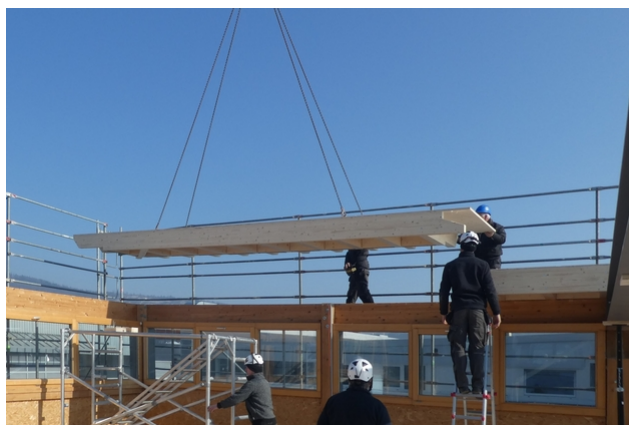
Pose d'un élément de toiture
