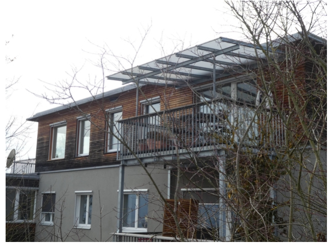
Façade après 10 ans
