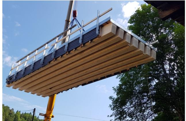
Un nouveau pont pour franchir le Seyon à Valangin ! L'ouvrage permet de relier la rue du Saut à la colline boisée qui surplombe Valangin. Ce nouveau pont est capable de supporter des charges allant jusqu'à 40 tonnes.
