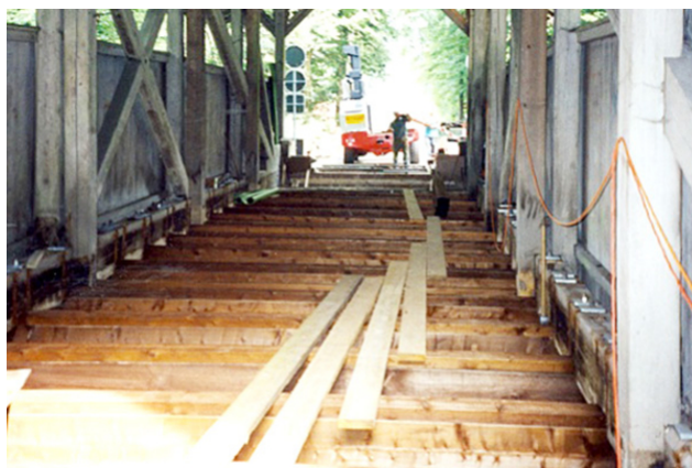
Montage de la traverse
