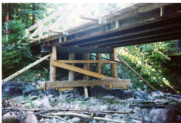
Pont de secours avec poutres en acier
