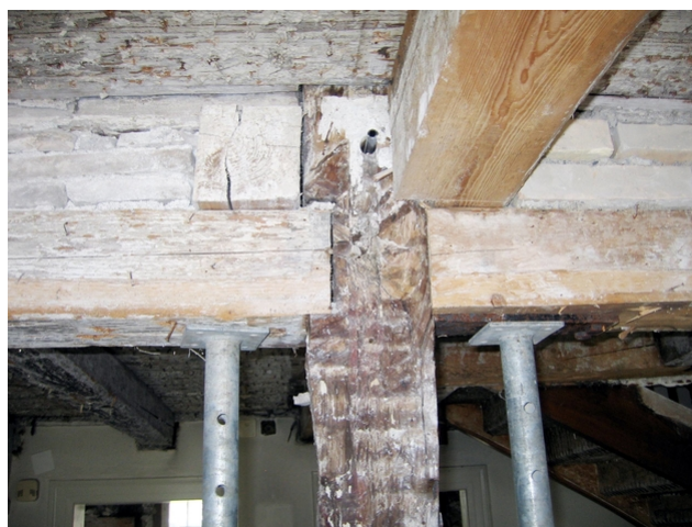
Soutien pour les poutres du rez-de-chaussée avant la rénovation
