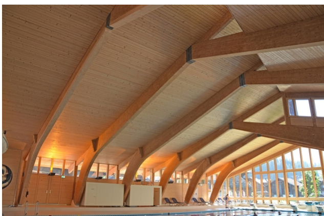
La poutre la plus à gauche est renforcée par des lamelles.
