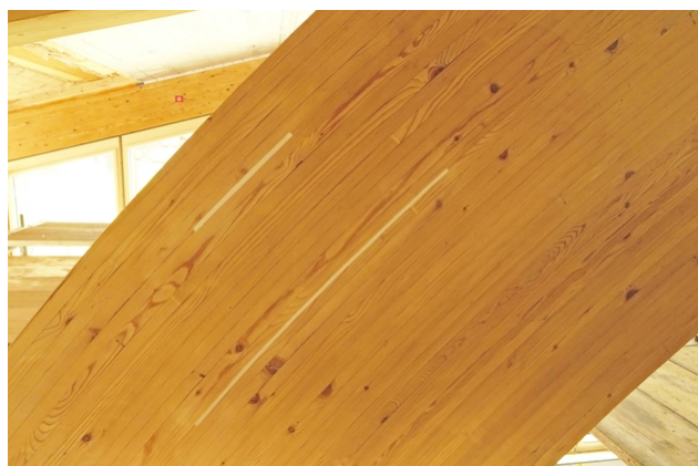
Vue détaillée d'un joint de colle rénové
