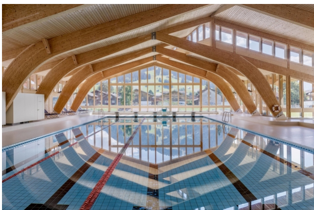
Des dimensions impressionnantes : structure porteuse de la piscine couverte
