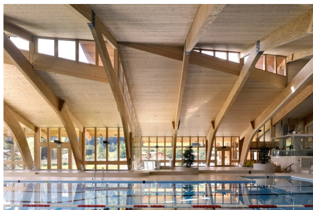
Les lambris acoustiques ont été remplacés entre les poutres.
