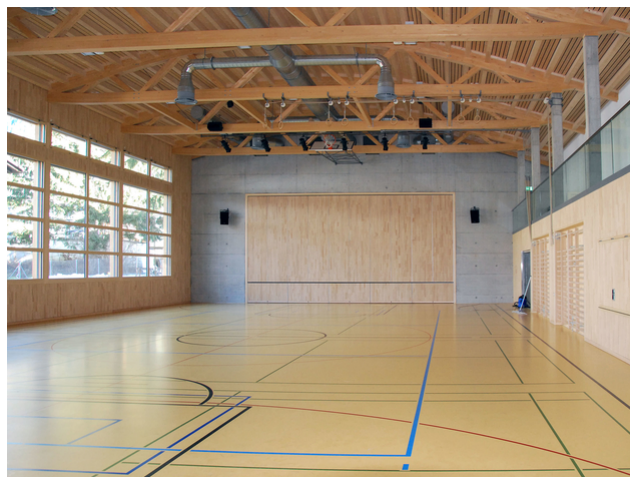
Suffisamment de place pour les tuyaux de ventilation grâce à la construction en treillis
