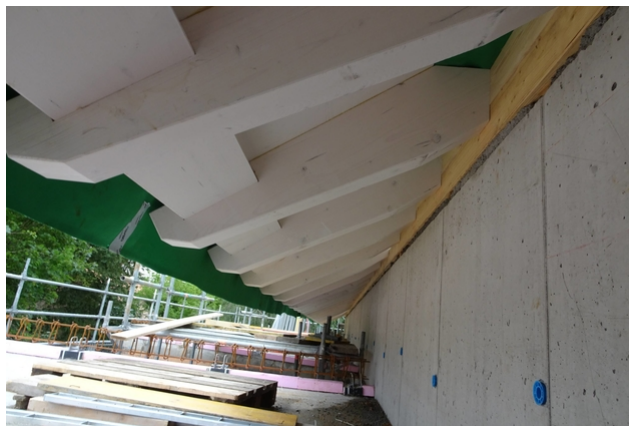
Avant-toit côté gouttière avec sticher
