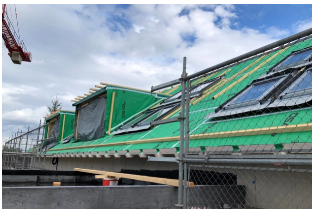
Surélévation en cours de construction
