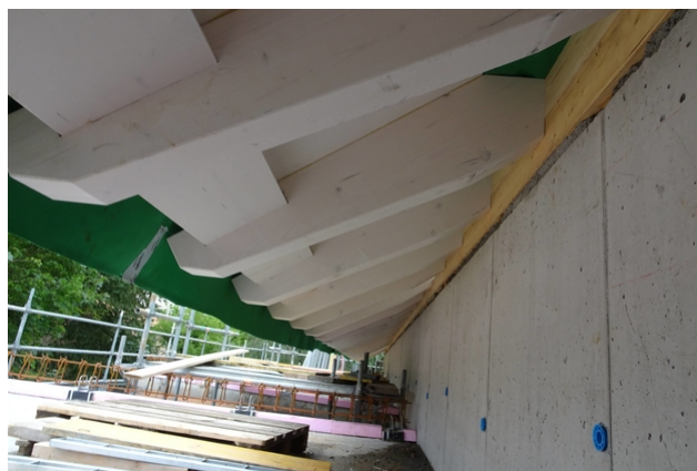
Avant-toit côté gouttière avec sticher
