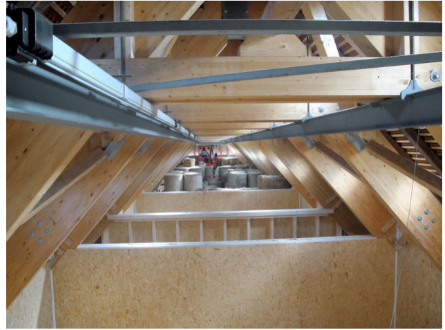
Voie de grue
