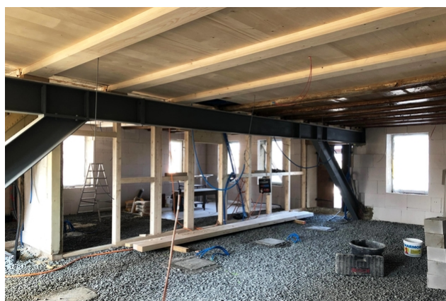
Poutrelles en acier dans un bâtiment ancien
