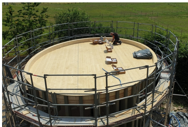
Scellement du joint TS3
