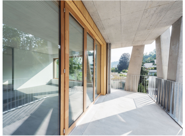
Opposition : une habitation en bois rencontre un avant-corps en béton
