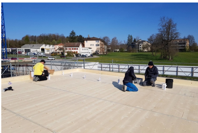
TS3 lors du scellement TS3 de l'&#039;avant-toit
