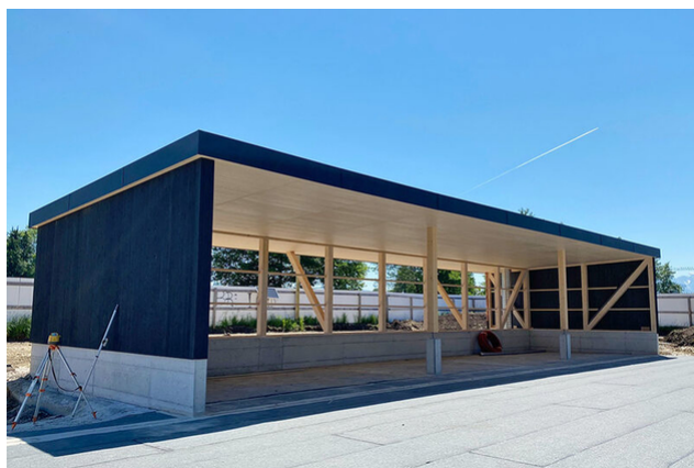
Couverture de la maison des conteneurs
