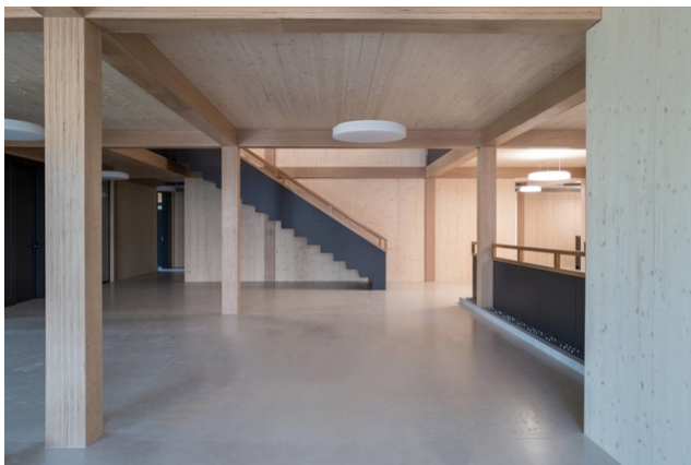
Vue intérieure avec supports en hêtre
