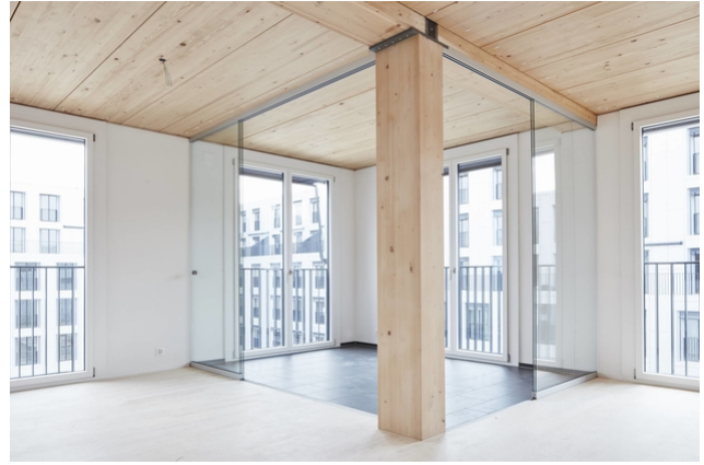
Loggia mit Stützen und Decken in Holzbauweise
