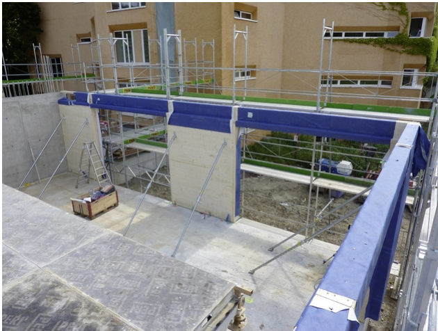
Im Bau: Zuerst wurden die Holzelemente eingebaut, dann die Decken betoniert
