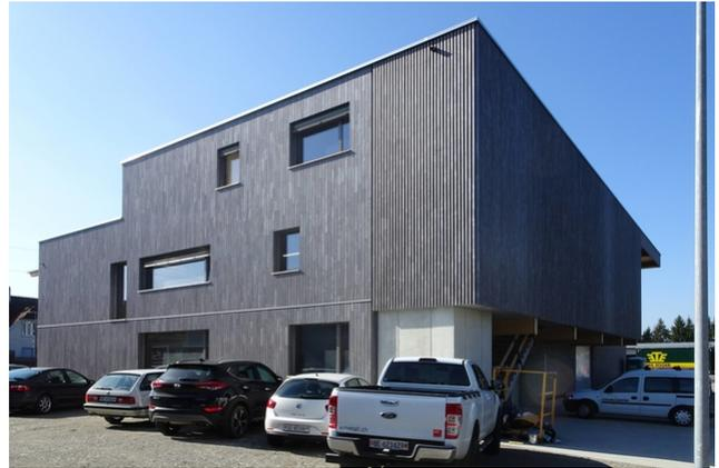
In Aefligen zwischen Bern und Solothurn entstand ein Gewerbegebäude mit verschiedenen Nebenräumen. Der Baukörper mit einem Volumen von über 6'000 Kubikmetern überzeugt mit seiner Tragstruktur und der Fassade aus Holz.
