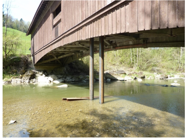
Provisorische Rammfähle zur Stabilisierung
