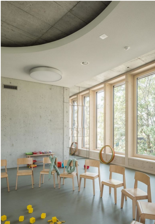
Innenansicht: Fassade in Holz. Darüber liegt die Betondecke
