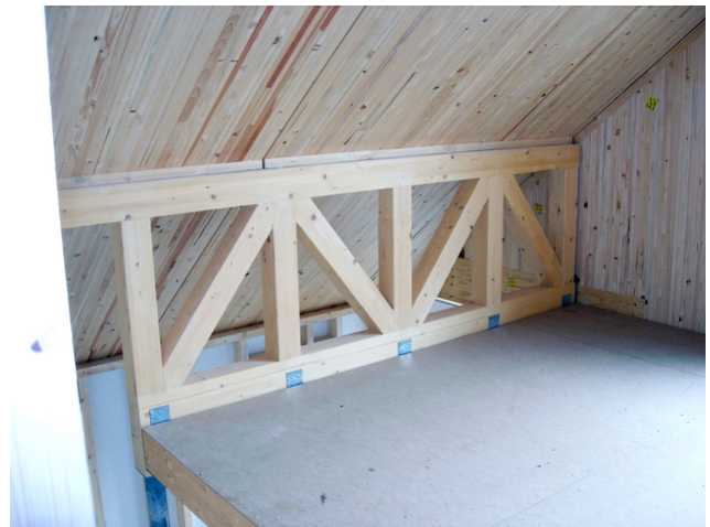
Galerie, Ansicht von oben
