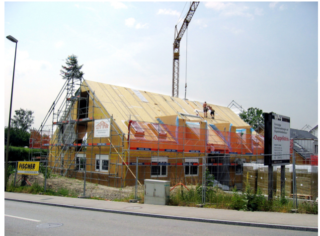
Vorbereitung Dachdämmung
