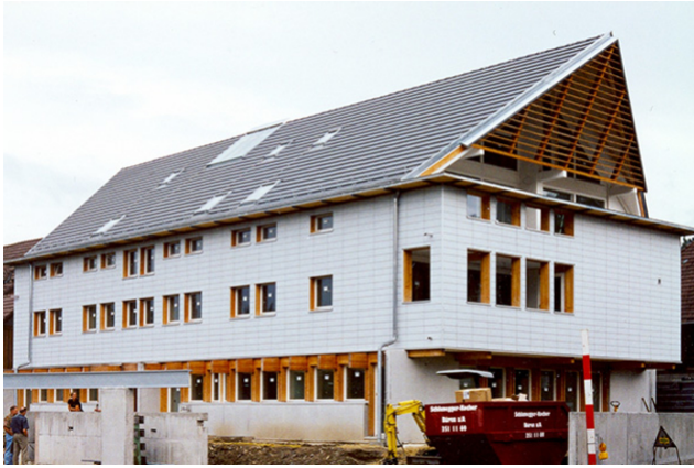
Ansicht von der Strasse
