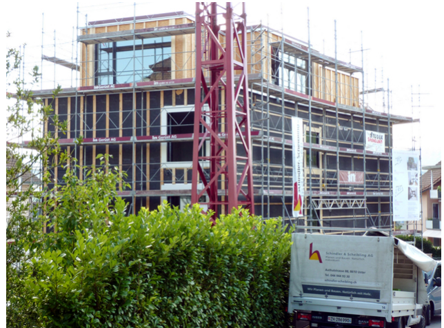
Aussenansicht strassenbseitig von oben im Rohbau
