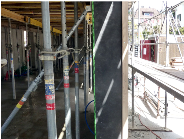
Tragende Holzwände EG vor dem betonieren der EG Decke
