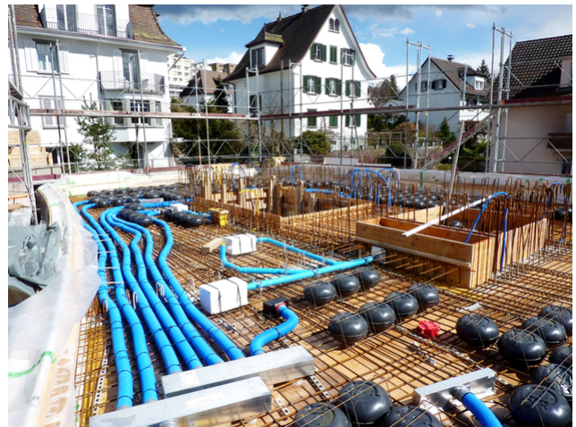
Betondecke über EG kurz vor dem betonieren
